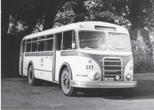
So präsentierten sich die Omnibusse des Typs H6B/S im Betrieb in Rostock. Markanter Unterschied zur Überlandausführung H6B/L sind die beiden Schiebetüren, während der H6B/L lediglich zwei Schlagtüren besaß. Bus 221 wurde 1956 angeliefert und stand bis 1974 in Rostock im Einsatz.
